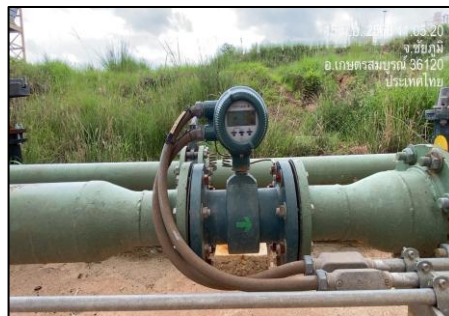
รูปที่ 2-25 Magnetic Flow Meter
