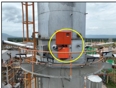
รูปที่ 2-3 เครื่องตรวจวัดคุณภาพอากาศจากปล่องแบบอัตโนมัติ (CEMs)
