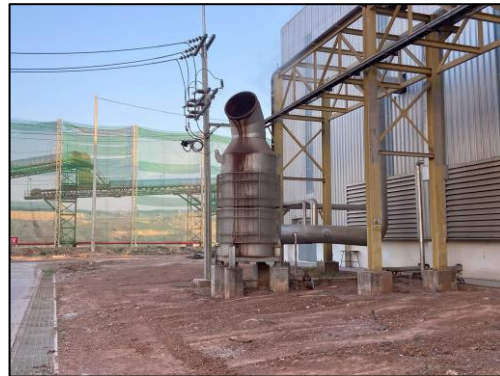
รูปที่ 2-32 วัสดุครอบปิดแหล่งกำเนิดเสียงดัง
