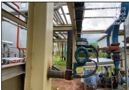
รูปที่ 2-25 Magnetic Flow Meter
