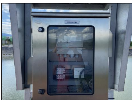
รูปที่ 2-28 เครื่องตรวจวัดคุณภาพน้ำทิ้งแบบอัตโนมัติ
