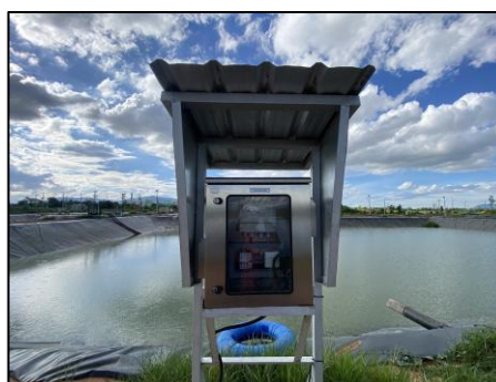
รูปที่ 2-28 เครื่องตรวจวัดคุณภาพน้ำทิ้งแบบอัตโนมัติ
