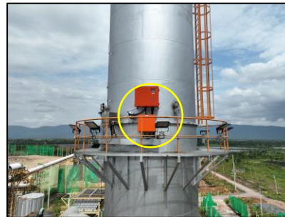
รูปที่ 2-3 เครื่องตรวจวัดคุณภาพอากาศจากปล่องแบบอัตโนมัติ (CEMs)
